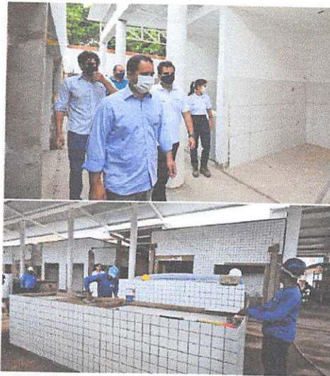
Prefeito Edivaldo acompanha andamento das Obras nos mercados e Praças (Bom Jesus)
